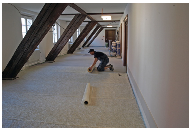
Étaler les lés d'UZIN RR 201 sur toute la surface à restaurer.
