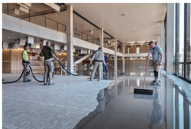
Enrobage d'UZIN RR 201 avec UZIN NC 170 LevelStar, à l'aide de la technique de pompage.
